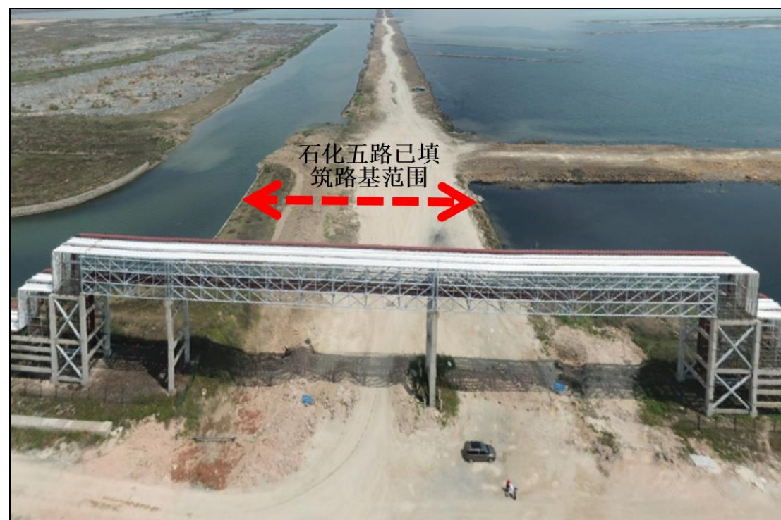
石化五路现状路基填筑图
