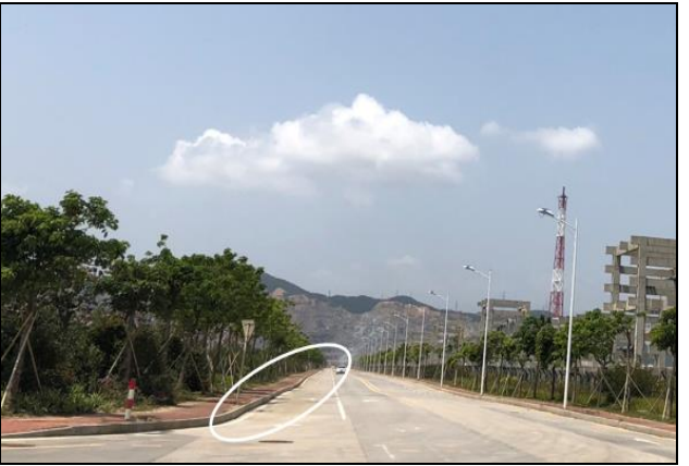
道路局部沉降图示（现状高栏港大道及石化六路）
