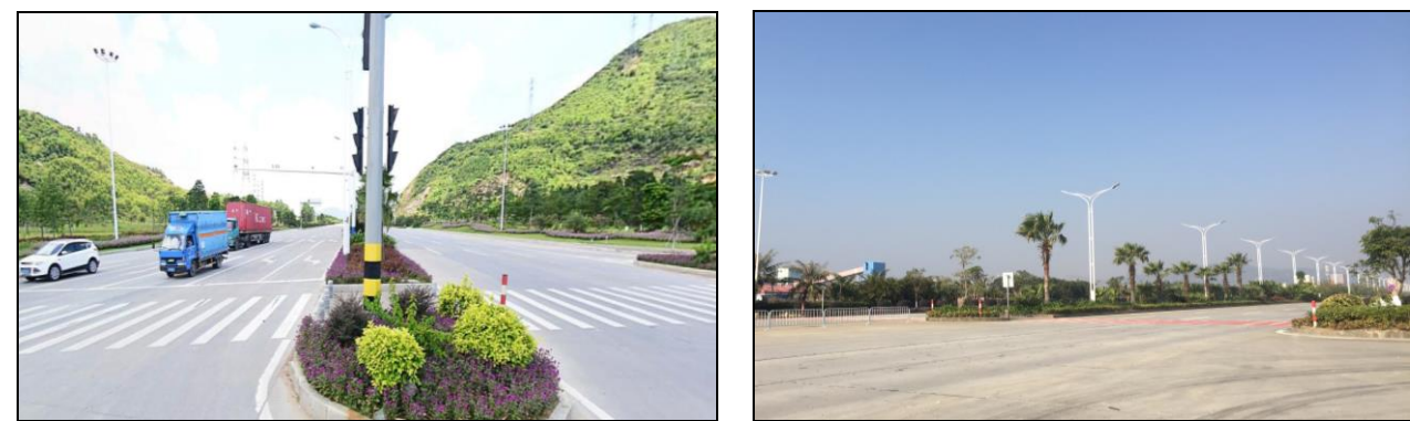
现状高栏港大道
