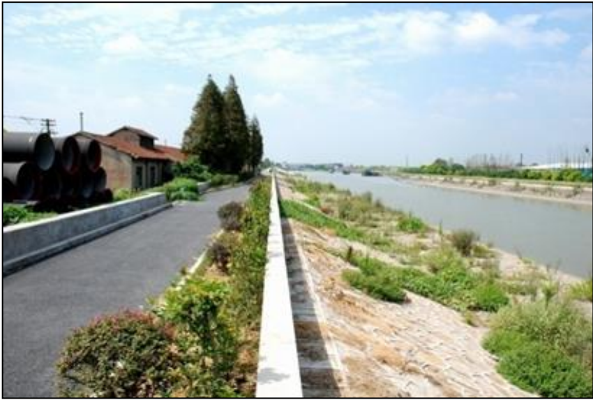
沿河生态护坡实景图
