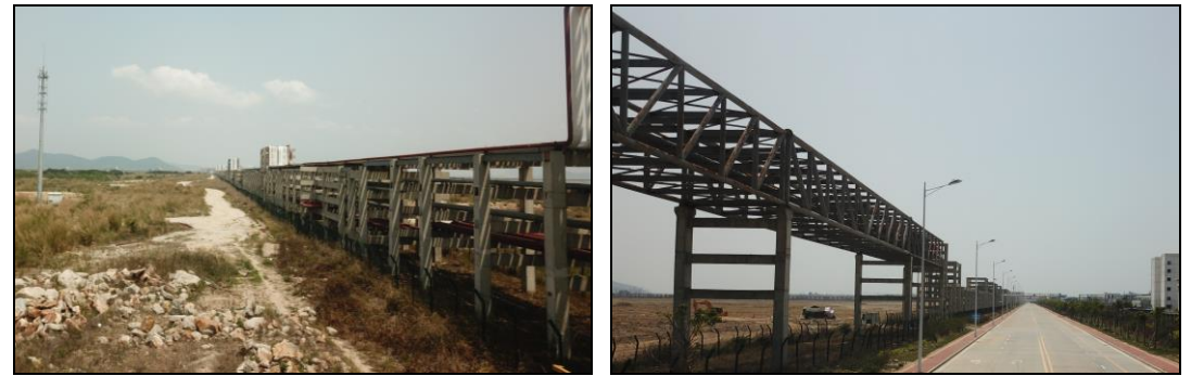
现状管廊设施带
