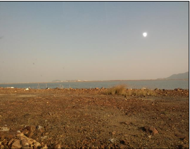
石化五路后半段填筑山皮石，外侧为水域
